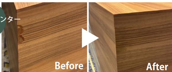
●家具表面材（メラミン化粧板）のリペア例 ※現場施工
