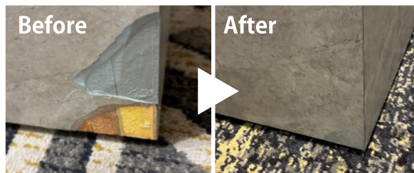
●家具表面材（メラミン化粧板）のリペア例 ※現場施工
